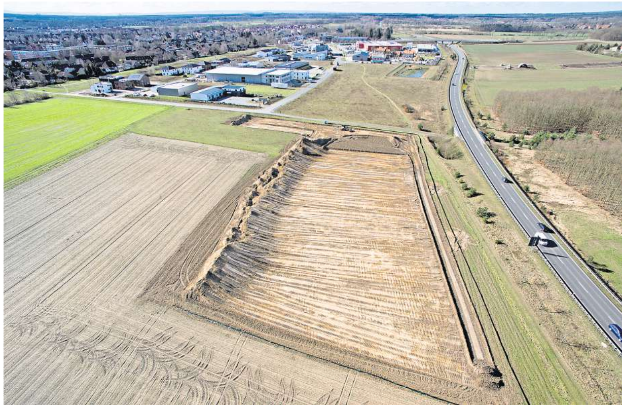
Die erste Baugrube: Im dritten Abschnitt des Gewerbeparks Nordwest ist sie bereits ausgehoben. FOTO: HOLGER SCHILKE
